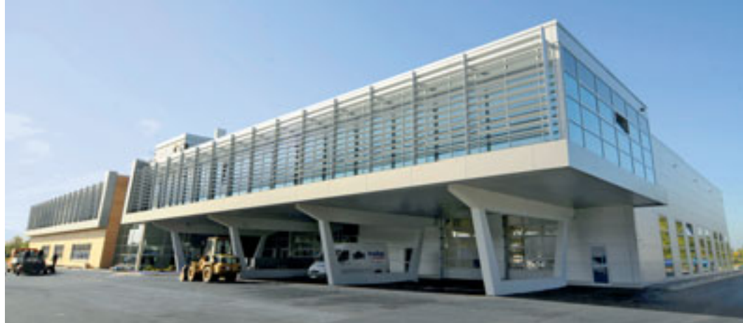
Une réussite architecturale : le nouveau centre d'impression et de logistique, à proximité de la bretelle d'autoroute de Bremerhaven-Geestemünde
