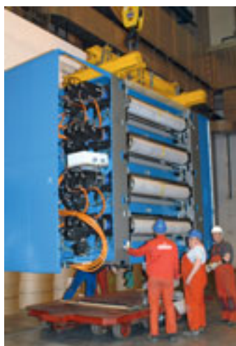
Les composants de la Cortina 6/2 amenés par le chariot de transport sont positionnés sur leur emplacement définitif
